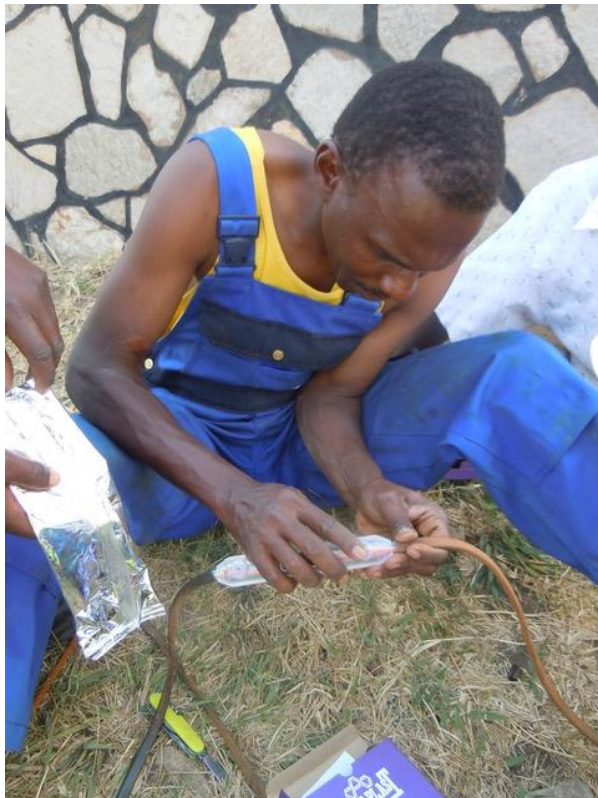
Bild: Sidney Cheelo beim Anschliessen der Wasserpumpe an das Stromnetz
